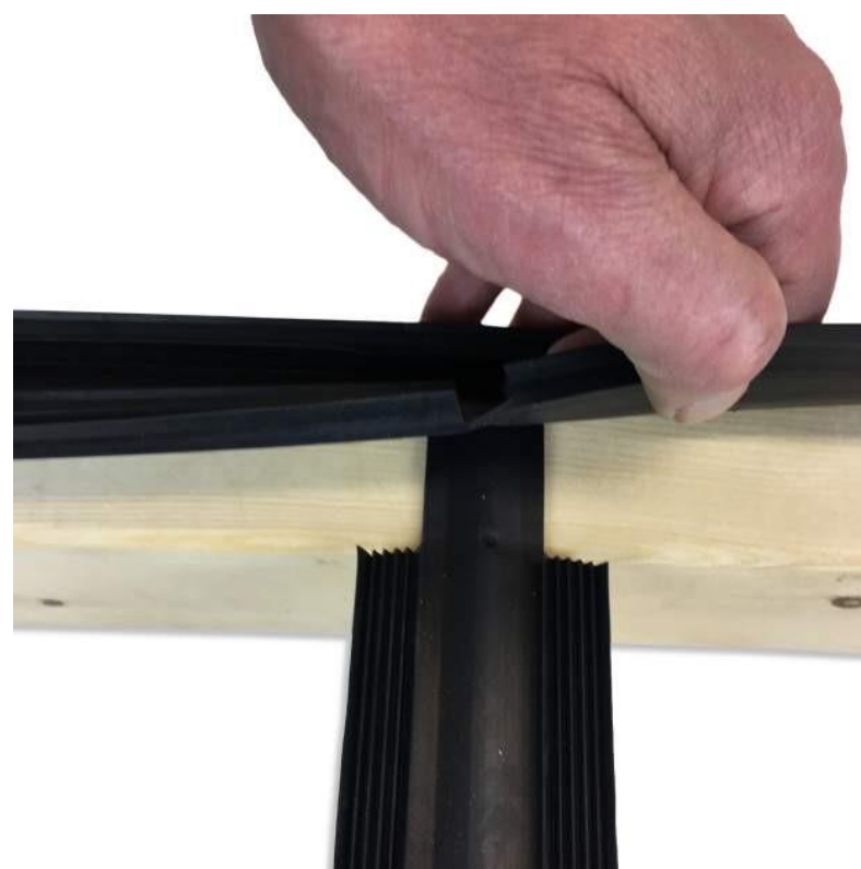
Udskæring midt toprem/spær gummibund
