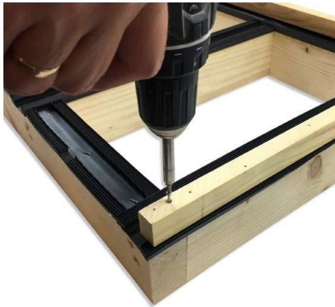
Afstandslisterne skrues fast, så de flugter med bærelamellerne
