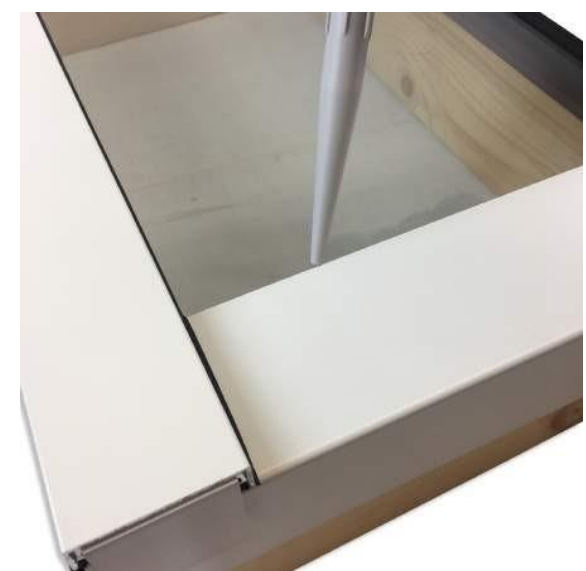
Fugning af bundvandnæse
