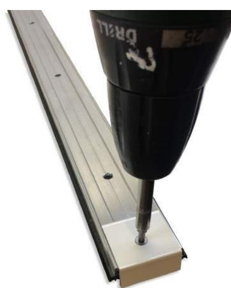
Profilafslutningen monteres på trykprofilen
